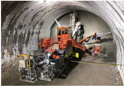
ロックボルト施工状況
